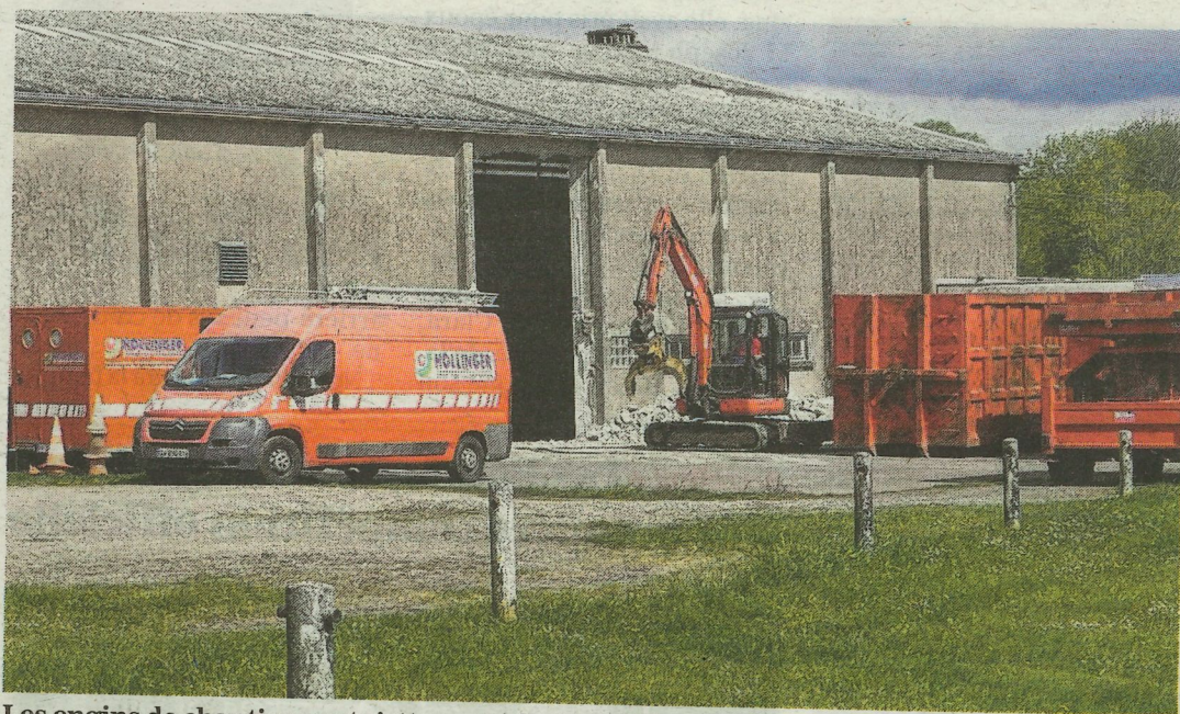
Les engins de chantier vont s'attaquer à la démolition des bâtiments existants.
