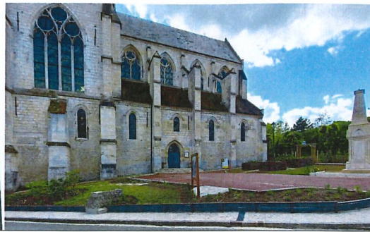
Aménagement de la place Aristide Briand : création de jardins d'aromatiques et d'un trottoir.
