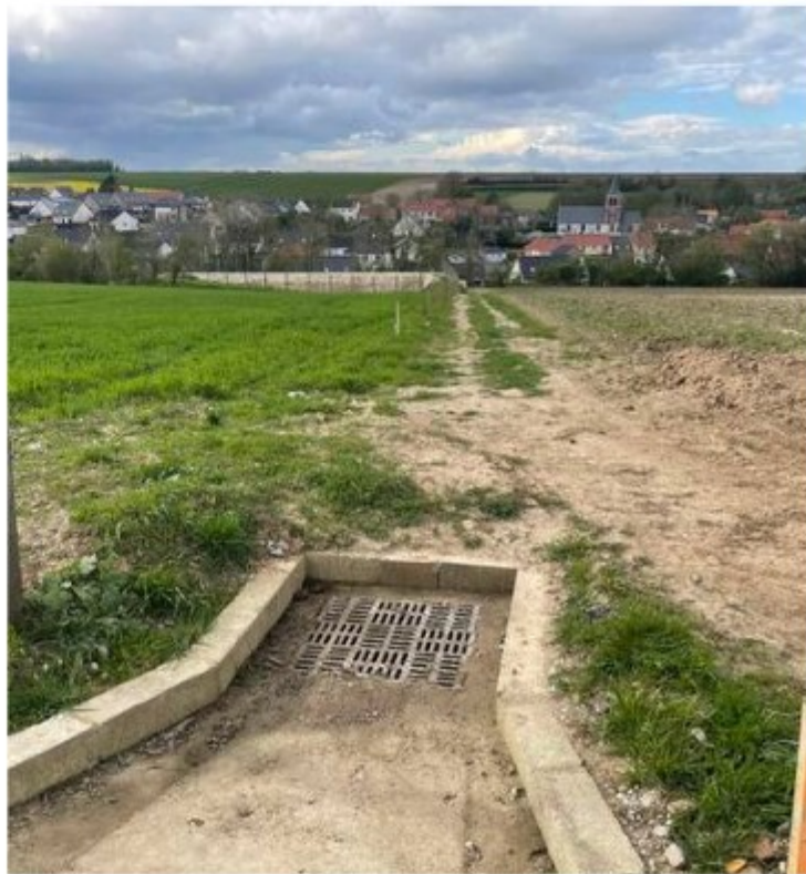
Le bassin est situé en surplomb d'un quartier résidentiel.
