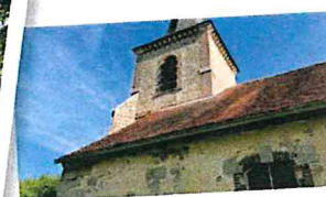
Démoussage des toits et changement des gouttières
