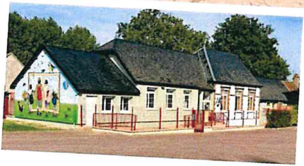
23 septembre : Inauguration de l'école rénovée
