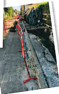
Travaux sur la rue Matignon: enfouissement des lignes électriques et rénovation du réseau d'eau potable
