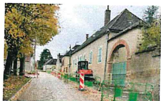
Travaux sur la rue Matignon: enfouissement des lignes électriques et rénovation du réseau d'eau potable
