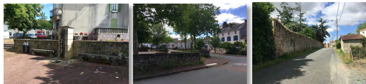
Mur de pierres sèches de Pays. Couronnement du mur en tuile tige de botte pour les murs hauts. Joints creux ou ciment
