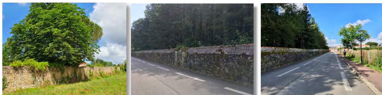
Mur de pierres sèches de Pays. Couronnement du mur en tuile tige de botte pour les murs hauts. Joints creux ou ciment
