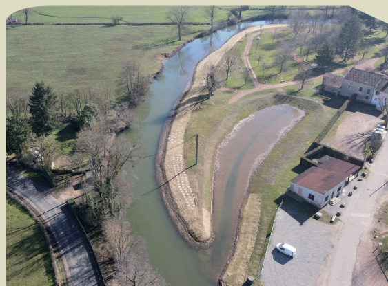
Restauration hydromorphologique localisée du Sornin entre Pouilly et Saint-Nizier
