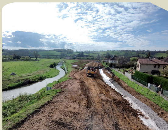
Construction de la nouvelle digue à Charlieu
