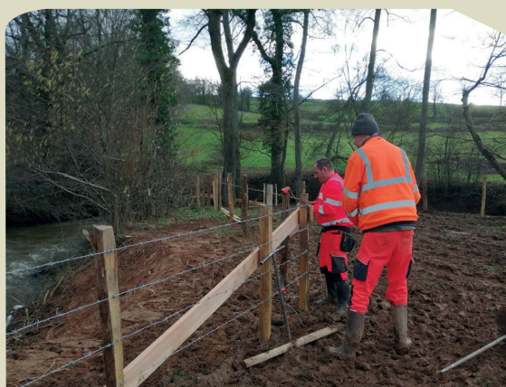
Travaux de mise en défens sur le Jarnossin
