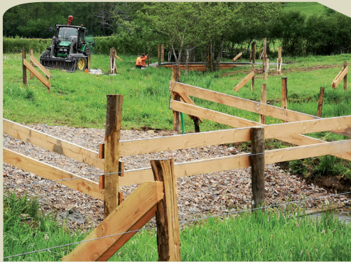
Travaux sur le ruisseau des Magourcines
