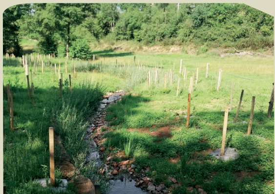
Bras de contournement pour restaurer la continuité au moulin de Jarnosse
