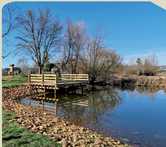
Restauration de l'étang des Gaces à Charlieu
