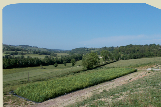
Filtre planté de roseaux de Saint-Maurice-les-Châteauneuf pour assurer l'assainissement des eaux usées
