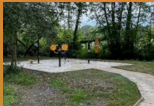
16 mai 2024. Cheminement et mise en place définitive des agrès.
