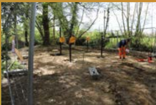
5 avril 2024. Pose de la structure des agrès.
