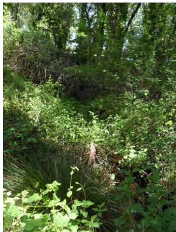
Figure 31 : Cours d'eau embroussaillé, près de la RN165 au nord de Talvern
