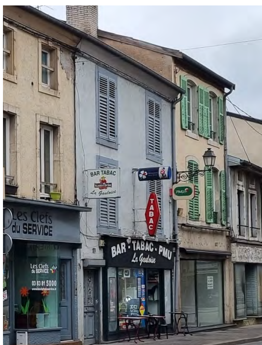
Enseignes perpendiculaires au mur sur une même façade, Pont-à-Mousson, novembre 2022.
