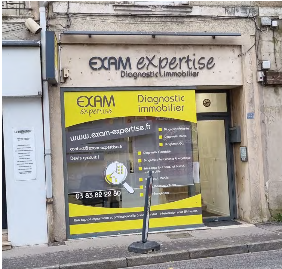
Façade commerciale dépassant à priori le seuil autorisé de surface cumulée d'enseigne sur façade, Pont-à-Mousson, novembre 2022.
