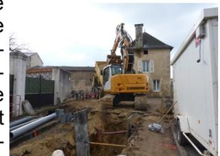
Nous avons aussi comme objectif de mettre en séparatif les eaux pluviales des eaux usées, il était donc nécessaire de réaliser les travaux de mise en séparatif des réseaux rue Etienne Saby
