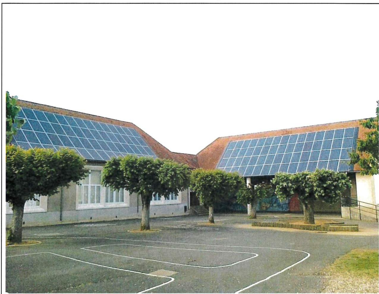
Puissance de 55,2 Kwc pour une surface de modules de 391 m2. Mise en service le 06/04/2011.
