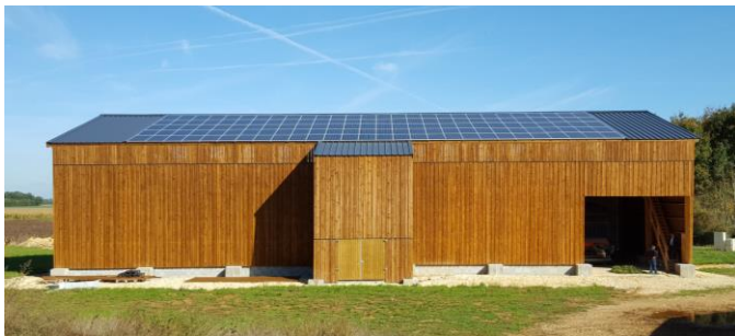
Séchoir de fourrage vrac – SCEA des Feuillages (86)
