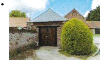
Bâtiment des pompes à incendie, vers 1901.
