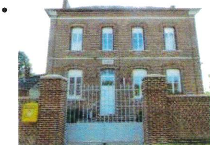
Façade sur rue de la mairie-école, n°34 Grande Rue, vue depuis le nord.
