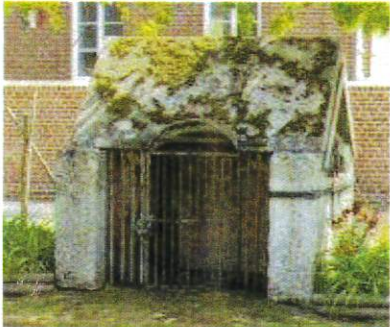
Puits en forme d'édicule architecturé, blocs de calcaire, en face de la mairie-école.
