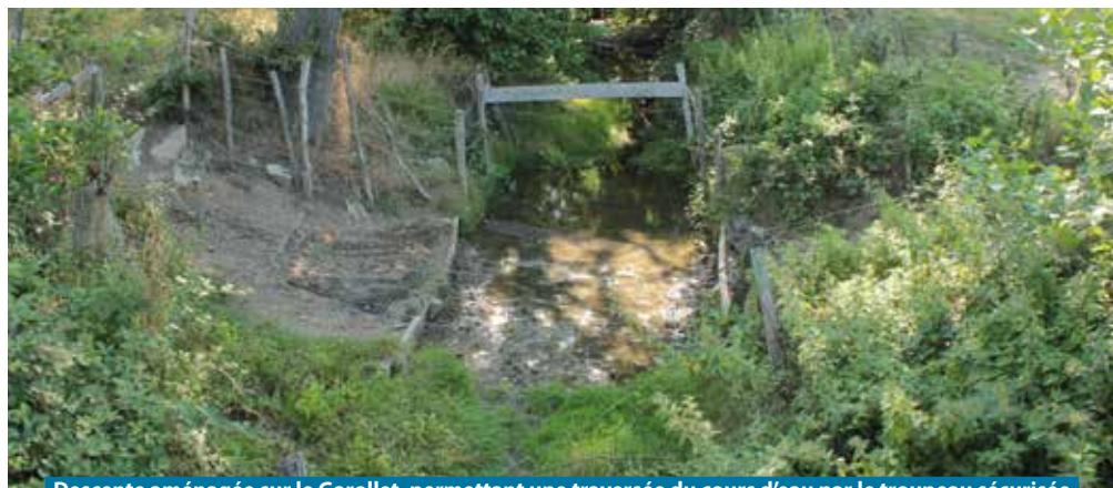
Descente aménagée sur le Garollet, permettant une traversée du cours d'eau par le troupeau sécurisée
