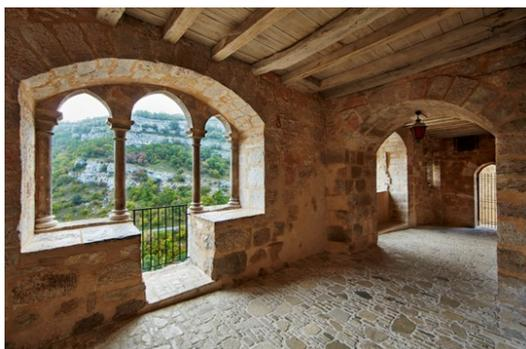
Par souci de sécurité, les entreprises ont également assuré la réfection des sols, la mise en place de mains courante et de garde-corps aux normes et d'un éclairage du cheminement sur le même principe que celui du chemin de croix (lumières intégrées dans les murets).
