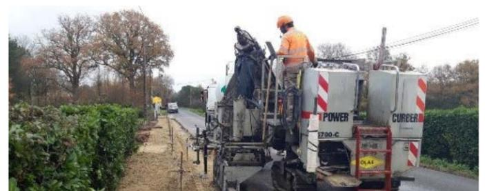
Concernant les travaux d'entretien, 40 tonnes de PATA (Point à Temps Automatique : émulsion de bitume et de gravillons) vont être répandus sur les chaussées les plus endommagées. Le but est d'assurer une meilleure étanchéité de la route et de prévenir le risque de création de nids de poule.
