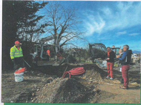
L'aménagement d'espaces verts avec plantation d'arbres se fera à l'automne.
