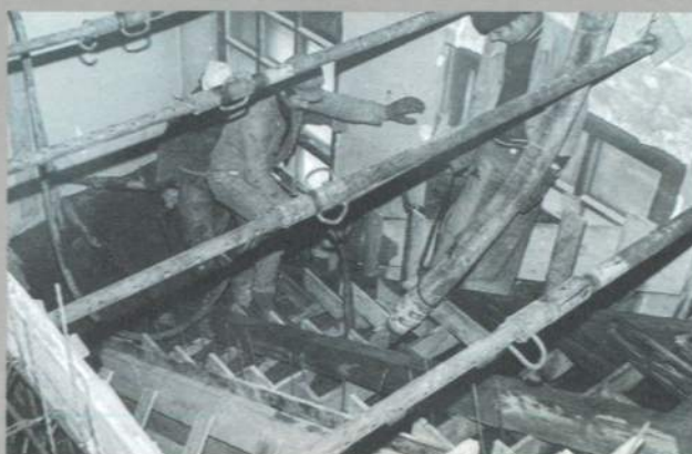
1951 : la remise en état
