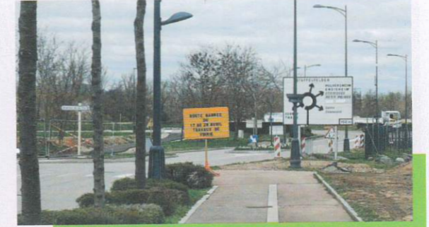
Un projet porté par m2A qui a partiellement financé les travaux ; 40 000 € ont été financés par la Ville au titre du plateau surélevé.
