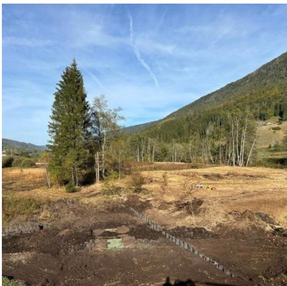
Palissade métalliques avant recouvrement et comblement du drain ©A.Robbe
