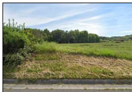
RD 709 coté est, partie Nord : talus et masque végétal
