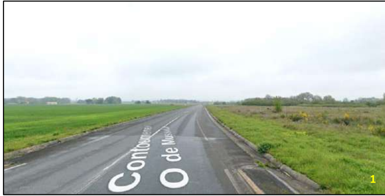
A la sortie du giratoire avec la RD 20 vers le Nord
