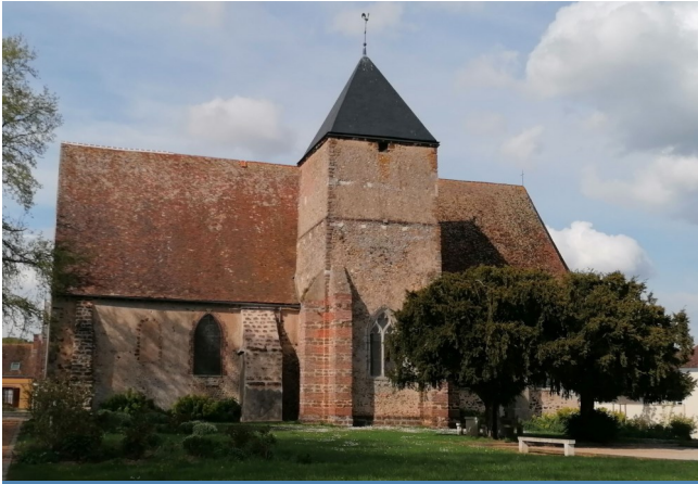
Réfection du côté sud de la toiture de l'église et de la sacristie
