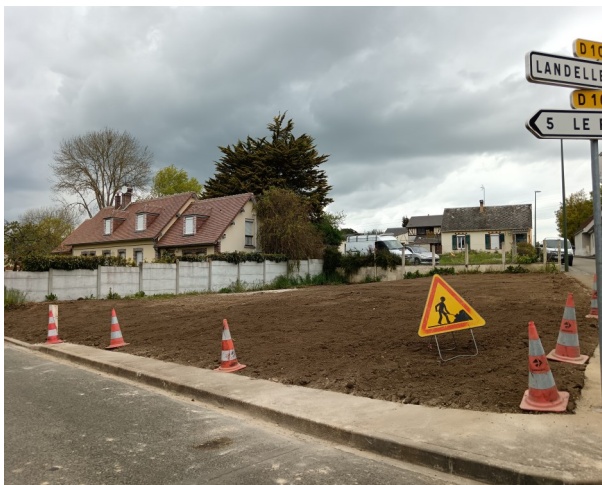
Démolition de la maison de Mr Antoëns en vue de l'aménagement de sécurité du carrefour
