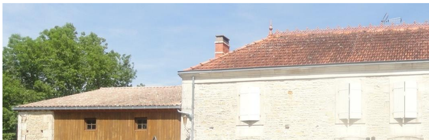
Couverture en tuiles canal sur l'ancienne dépendance, et tuiles plates sur le corps principal d'une maison de maître au Village de la Sèvre au Mazeau
