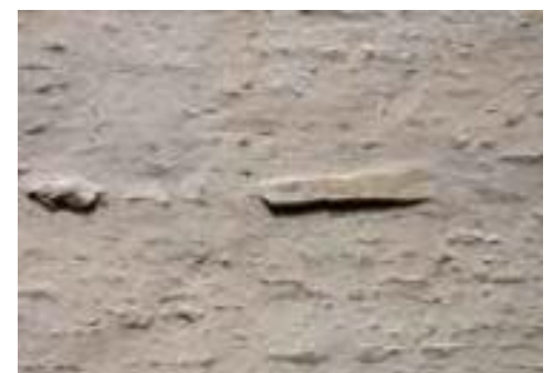
Les mortiers et enduits sont faits de terre, de sable locaux et de chaux. L'enduit à pierres vues laisse apparaître les moellons de pierre.
