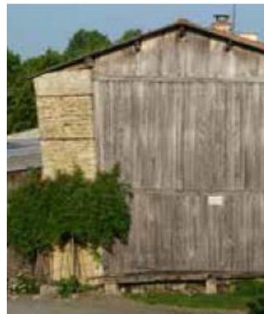
Peuplier en bardage sur un balet traditionnel
