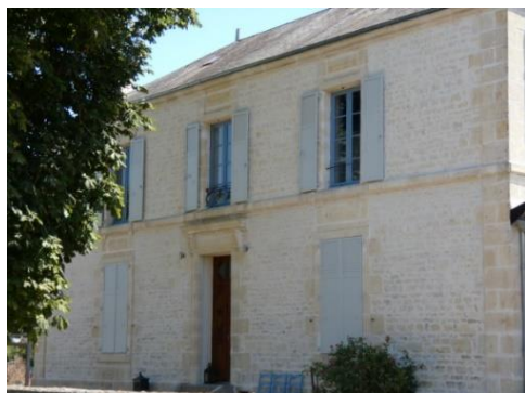
Maison de maître ; Moulin du Château Musset (disparu), puis ferme, allées du Château
