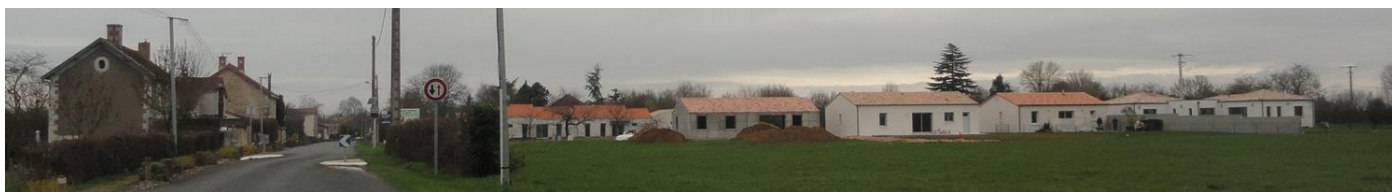
Vue d'ensemble sur l'entrée Est Route de Benet ; une haie va venir intégrer le nouveau lotissement
