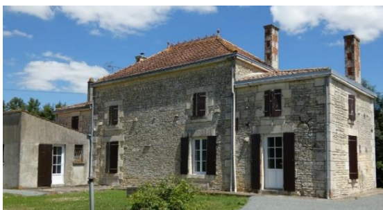
Maison de maître ; Village de la Sèvre Datation : 1er quart 20e siècle
