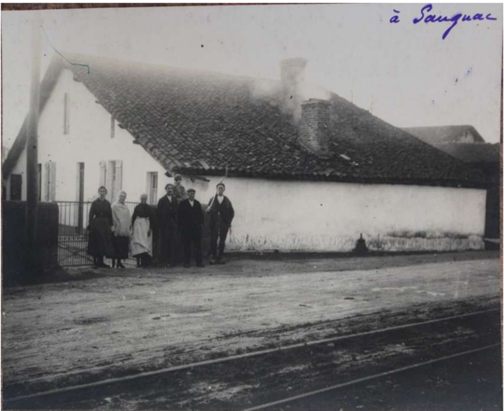
La ferme de Bergay à Sanguac et Cambran (1630 route d'Orthez), la chaussée et les rails
