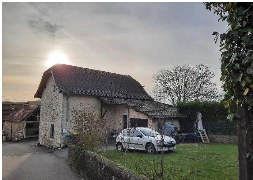
Rénovation du logement Installation d'une cuisine équipée en 2021
