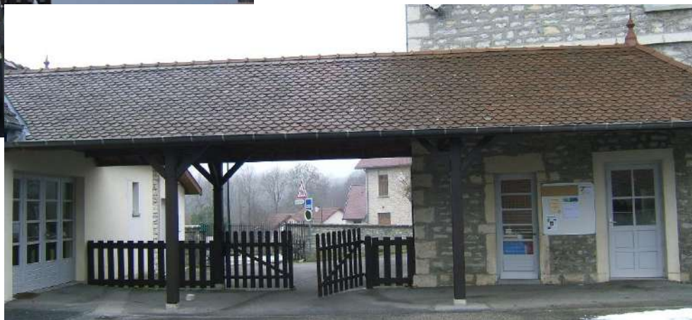
Travaux d'aménagement 2013 et 2014 Habillage des bandeaux en 2013
