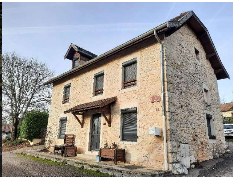
Réfection au RDC en 2016
