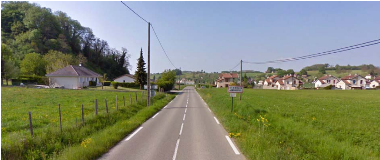
RD16b, entrée d'agglomération Est
