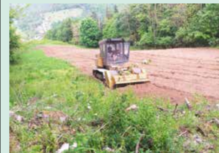
Durant les travaux de préparation du sol.
