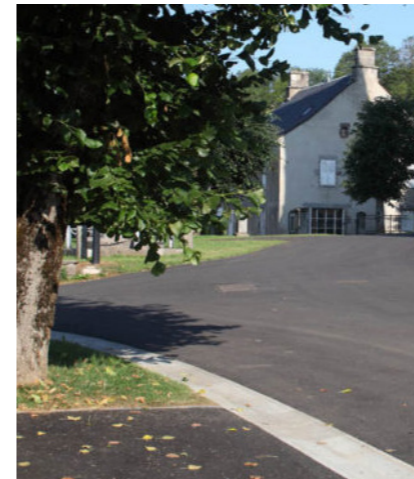
Voirie - Enrobé / Bordures et caniveaux en béton
