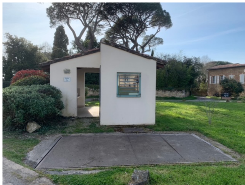
Démolition des toilettes existantes
