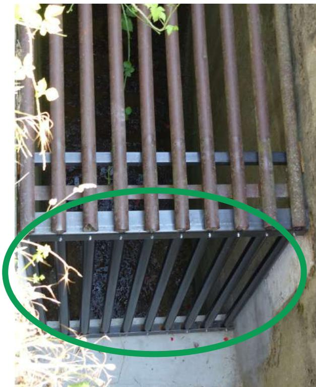
Remplacement de la paroi en béton par une grille
