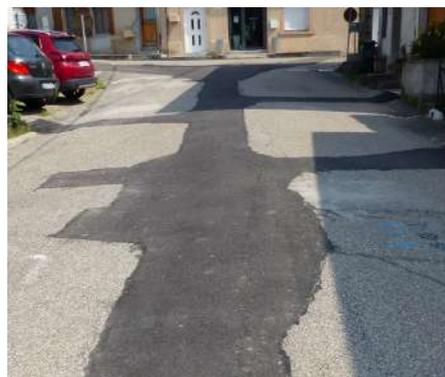
Le chantier de mise en séparatif eaux pluviales / eaux usées s'est achevé après un trimestre de travaux. Les riveains sont raccordés aux réseaux. Il ne reste plus que les finitions de revêtement de tranchées à réaliser après une période nécessaire de tassement.
