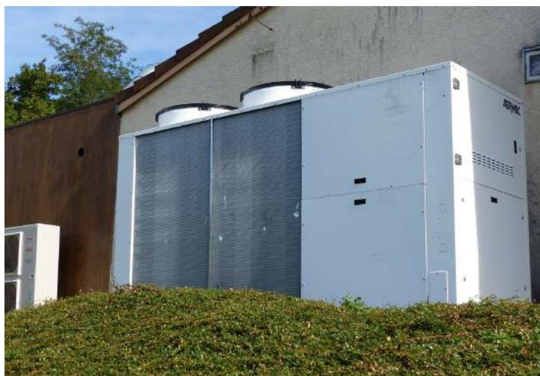
*PAC (pompe à chaleur) compresseur et échangeur pour le chauffage*
