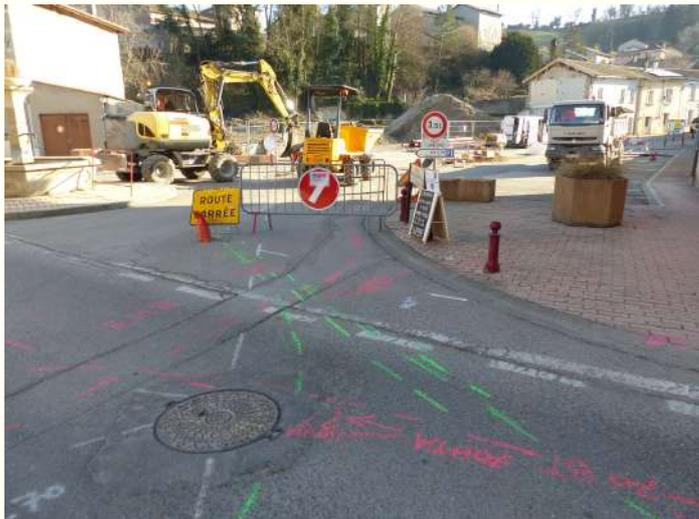
Repérage des différents réseaux souterrains après détection.
