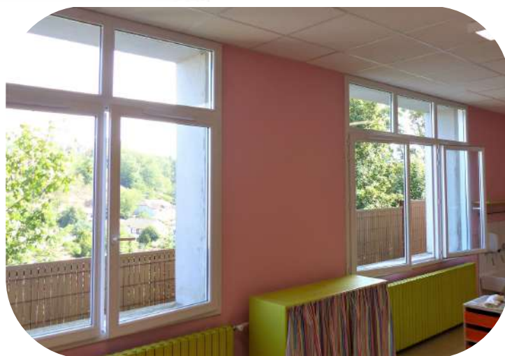
Doublage des murs de la classe des Grandes Sections et changement des menuiseries.
