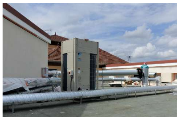
L'école maternelle qui était exclusivement chauffée avec l'énergie électrique est, aujourd'hui, équipée d'une Pompe à Chaleur (PAC) alimentant des climatiseurs réversibles.
