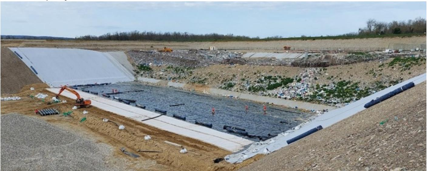
Finition par 50cm de galets roulés et séparation hydraulique des alvéoles
