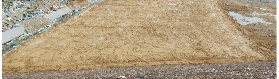
Pose de la barrière active en 3 couches : Géotextile synthétique bentonitique, géomembrane PEHD et feutre anti-poinçonnant
