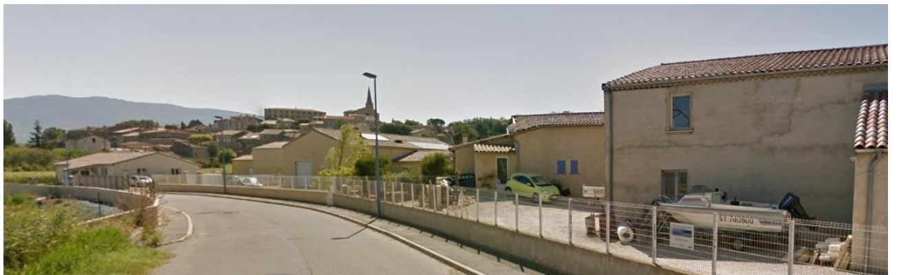
Figure 55. Vue sur le secteur des Boudras en direction de l'Est – covisibilité avec la ville médiévale
