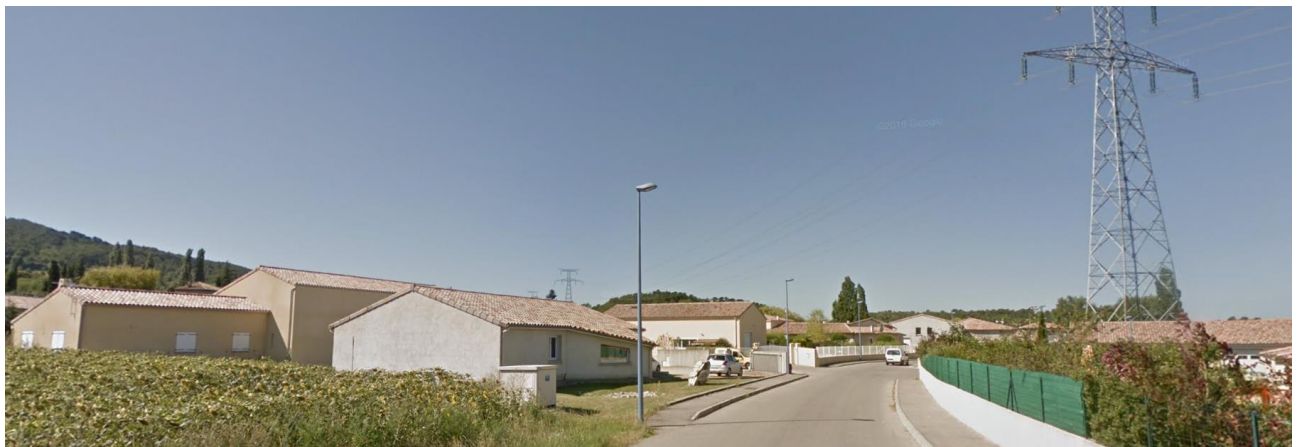
Figure 54. Vue sur le secteur des Boudras en direction de l'Ouest/ site sous électrique HT
