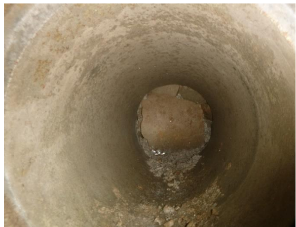
Vue intérieure de la conduite n°5
