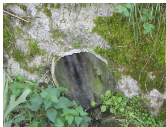
Exutoire du DO4 – Amont SR Boudras
