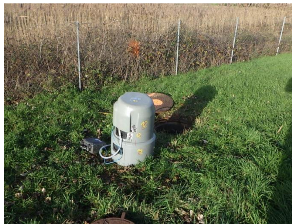
Vue extérieure sortie STEP
