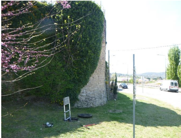
Vue extérieure du regard d'accès
