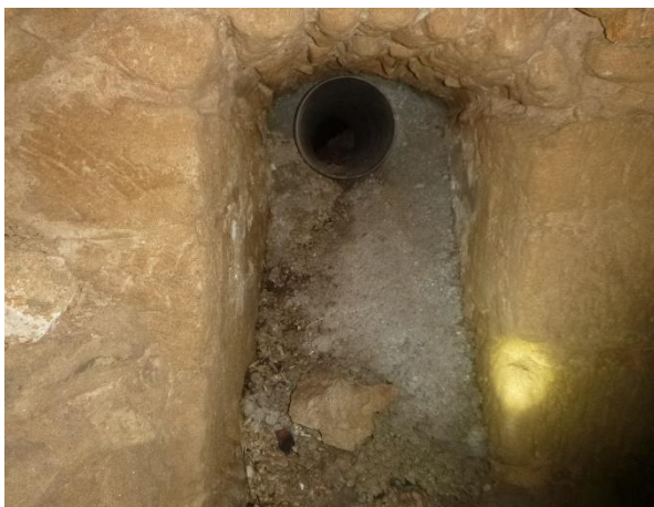
Conduite n°2 - 300 PVC ?
