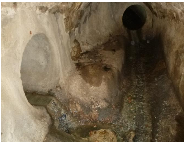
Vue des conduites EU : 500 Béton à gauche et 400 Béton au fond
