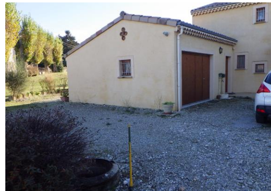
DO3– Vue extérieure
