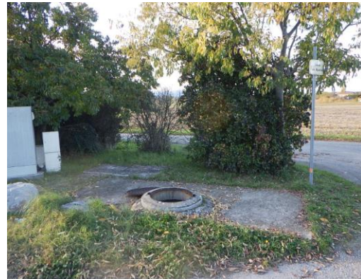
DO4– Vue extérieure
