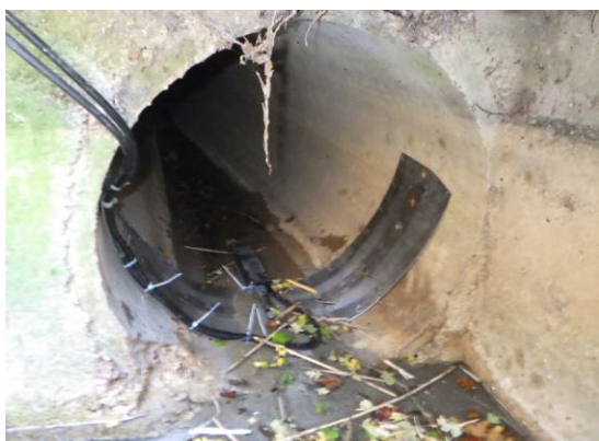
Exutoire du DO3 – Chez Gardia
