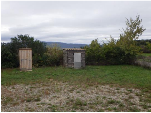
Relèvement entrée de station
