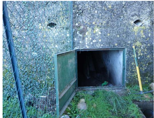
DO2– Vue extérieure
