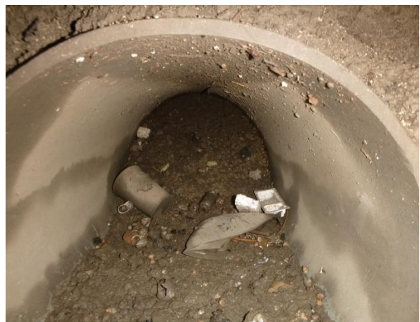
Vue intérieure de la conduite n°6
