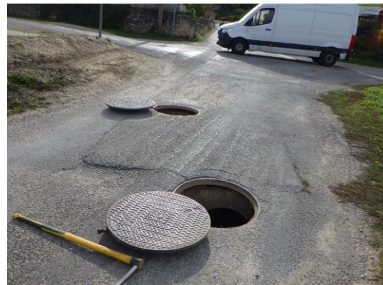
DO1 – Vue extérieure
