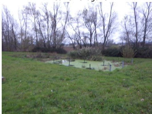
Filtres à sable
