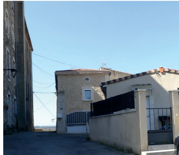
Façade en crepis
