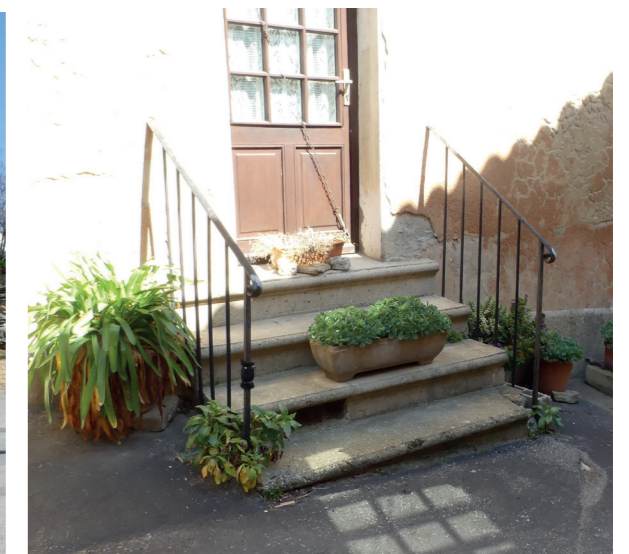
Végétalisation de pied de porte
