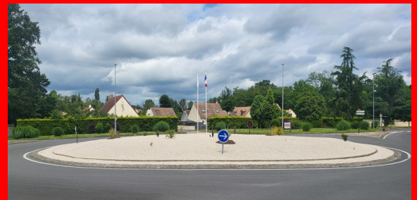
Nouvel aménagement du rond-point de la Valotte
