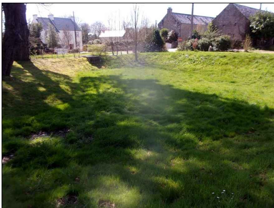
Photo 7 : Vue du bassin d'orage du lotissement Pro-Braz
