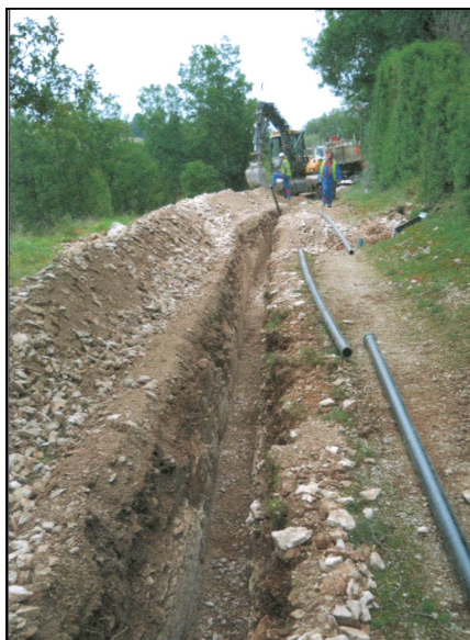
Renouvellement de canalisations sur le secteur des Campagnes
