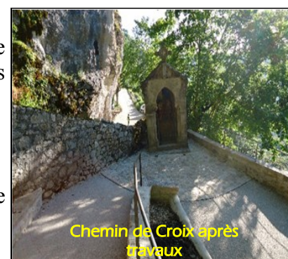
Chemin de Croix après travaux
