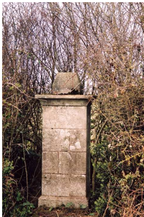
Vue du sud (route de Paulx)
