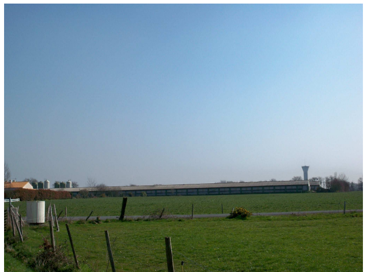
Les bâtiments hors sol, posés sur le terrain - Ph 14
