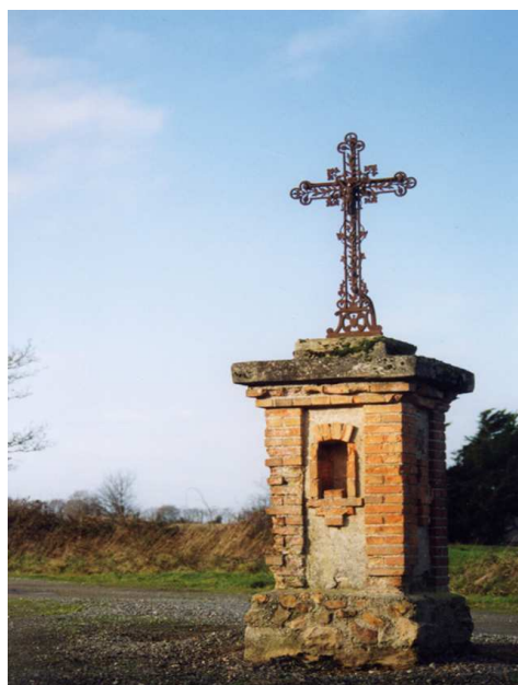
Vue de la route de Touvois au sud
