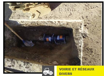
Moyens mécaniques mis en œuvre pour réaliser les travaux et la vanne de piquage posée assurant une étanchéité parfaite du réseau.
