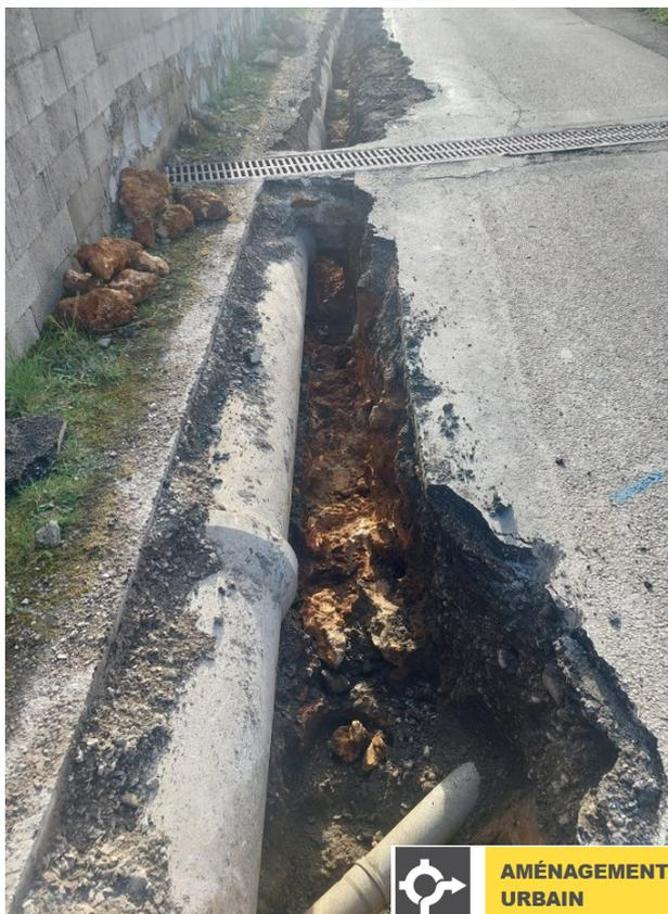
Travaux sur le réseau des eaux usées chemin des Muletiers afin de permettre de nouvelles constructions.
