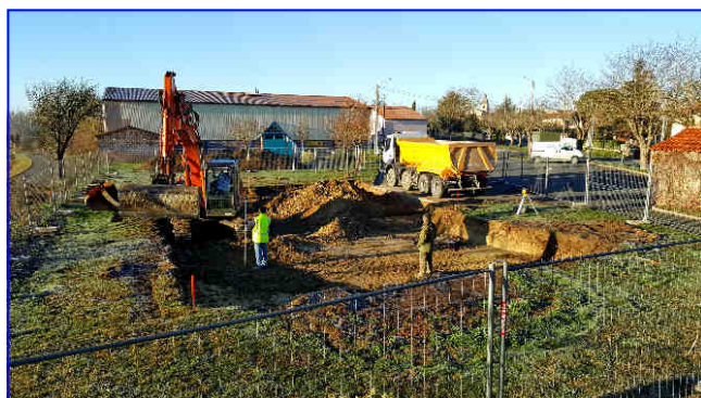
☞ Début du terrassement le 1 er décembre 2016
