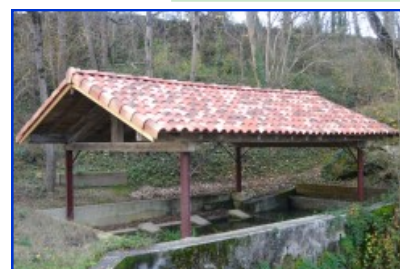
↳ Résultat après travaux
