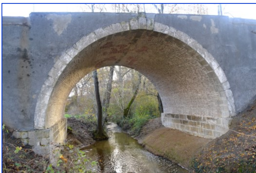
↳ Aperçu des travaux terminés
