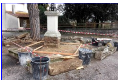
↳ Travaux de réparation
