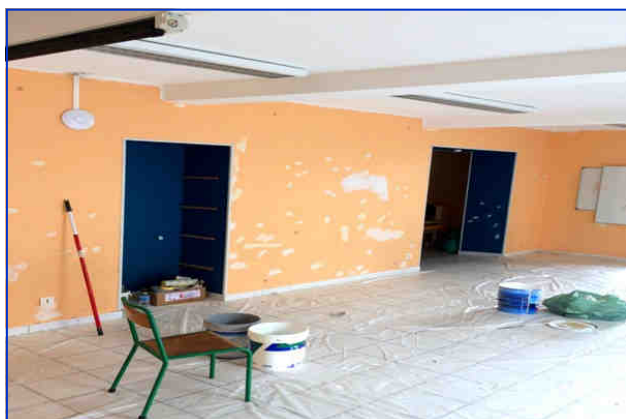
↳ Pendant les travaux
