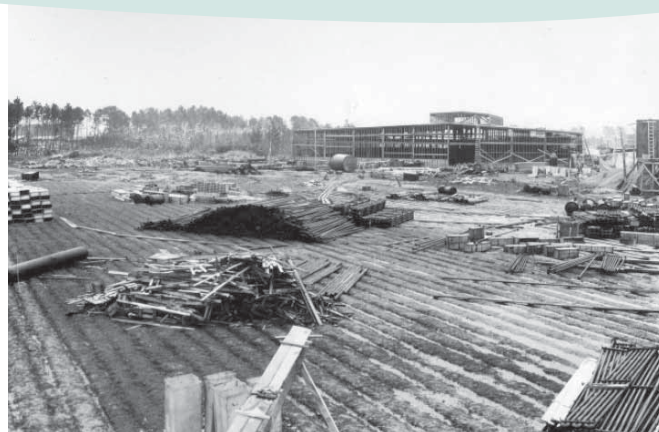
Construction de l'usine frigorifique à Gièvres
