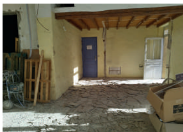
Le bâtiment avant travaux
