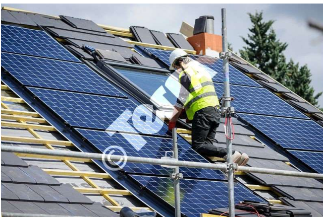
Entreprise ENERPUR : Chantier de pose de panneaux photovoltaïques sur le toit d'une maison individuelle
