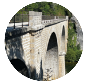
Viaduc à Cléron
