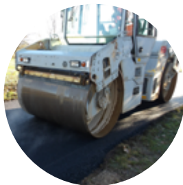
Travaux de voirie à L'Hôpital-du-Grosbois
