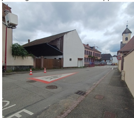
Vue sur une partie de l'emprise foncière concernée par l'ER6 dans le prolongement de l'école
