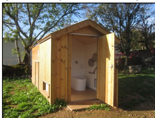
Le sanitaire à lombricomposteur en place à l'Hospitalet, qui sera ensuite déplacé au parking des garennes.
