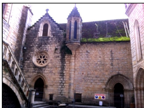
Travaux de couverture en cours sur les chapelles Sainte Anne et Saint Blaise – Décembre 2017
