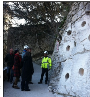
Travaux en cours Février 2017
