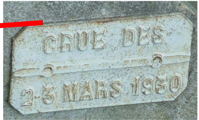
Repère de la crue de 1930 sur la culée du pont, rive gauche en aval
