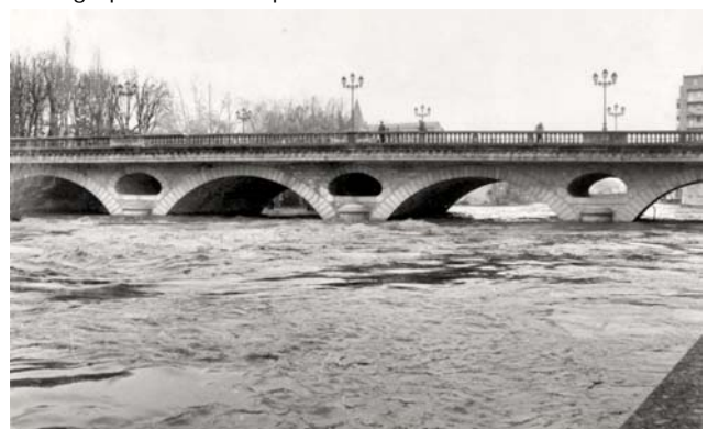
Le Pont de Castres sur l'Agout – crue de 1995 Photographie La Dépêche du Midi
