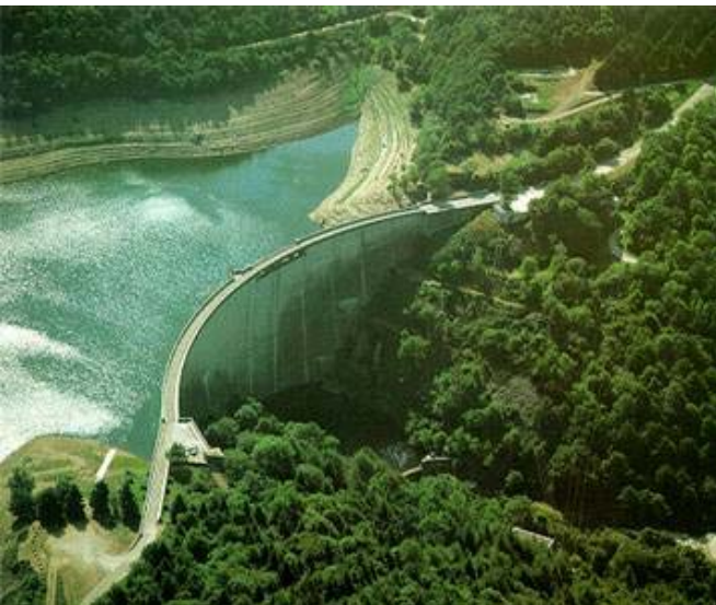
Barrage des Cammazes sur le Sor (cliché site ISL)
