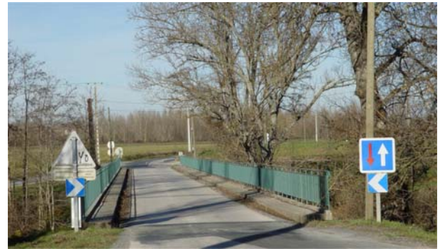
Pont de Fréjeville sur l'Agout – D 50
