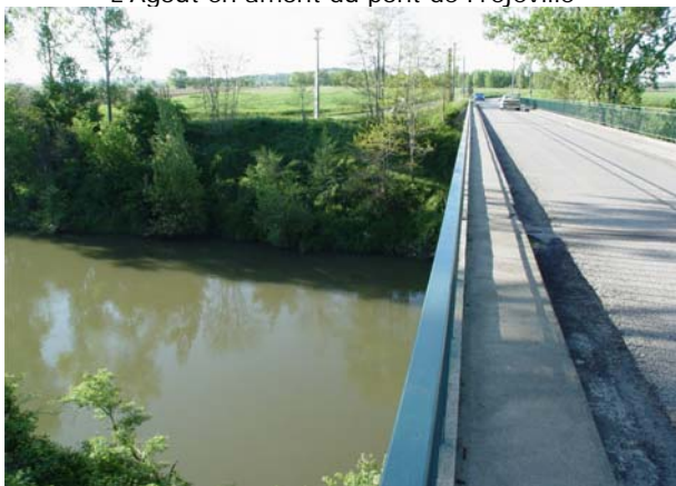
Plaine de Fréjeville en aval du Pont
