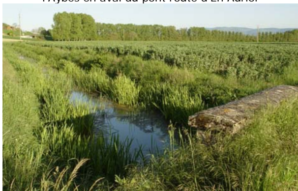
Ponceau sur la Nauze à proximité de la Nogarède
