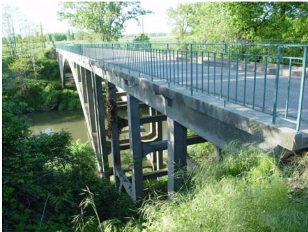
Pont de Fréjeville sur l'Agout - D 50
